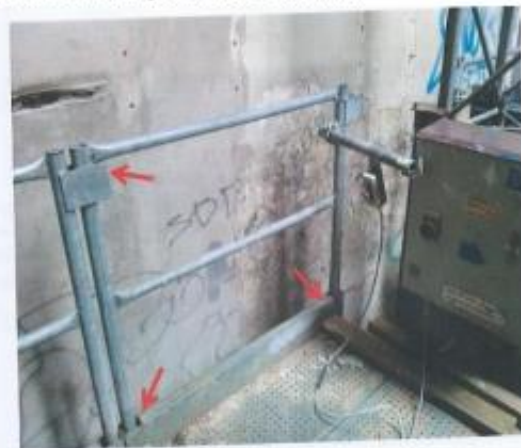
4. fotoattēls. Platformas MA1200 margu posms, kas bija izņemts maisu iekraušanas darbība laikā, kad platforma atradās 5. stāva loga ailēs līmenī. Margu posms ir viegli noņemams pēc vajadzības.
