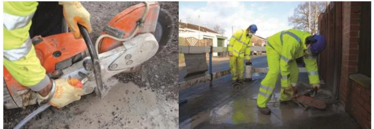
Fotogrāfijās attēlota sistēmas putekļu slapēšanai ar ūdeni
